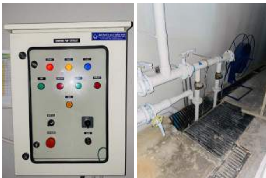
ภาคผนวกที่ 2.4 เครื่องสูบน้ำทิ้ง และตู้ควบคุม
