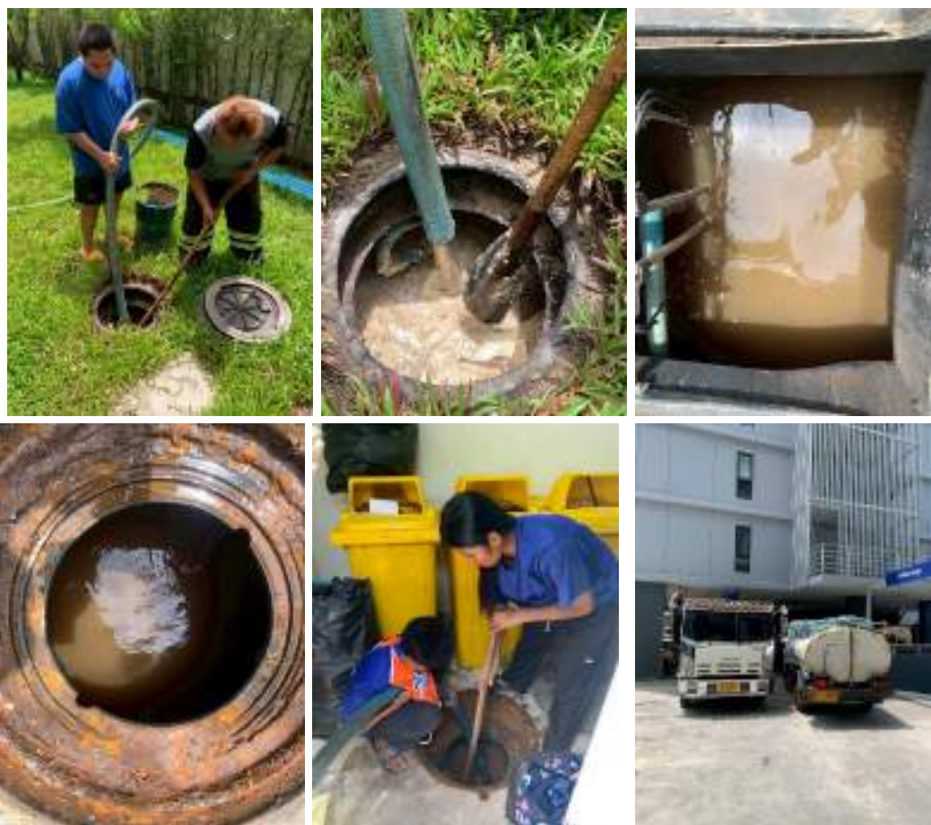
ภาคผนวกที่ 2.6 : จัดจ้างหน่วยงานเอกชนเข้ากำจัดกากตะกอนระบบบำบัดน้ำเสียตามที่กำหนด (ต่อ)
