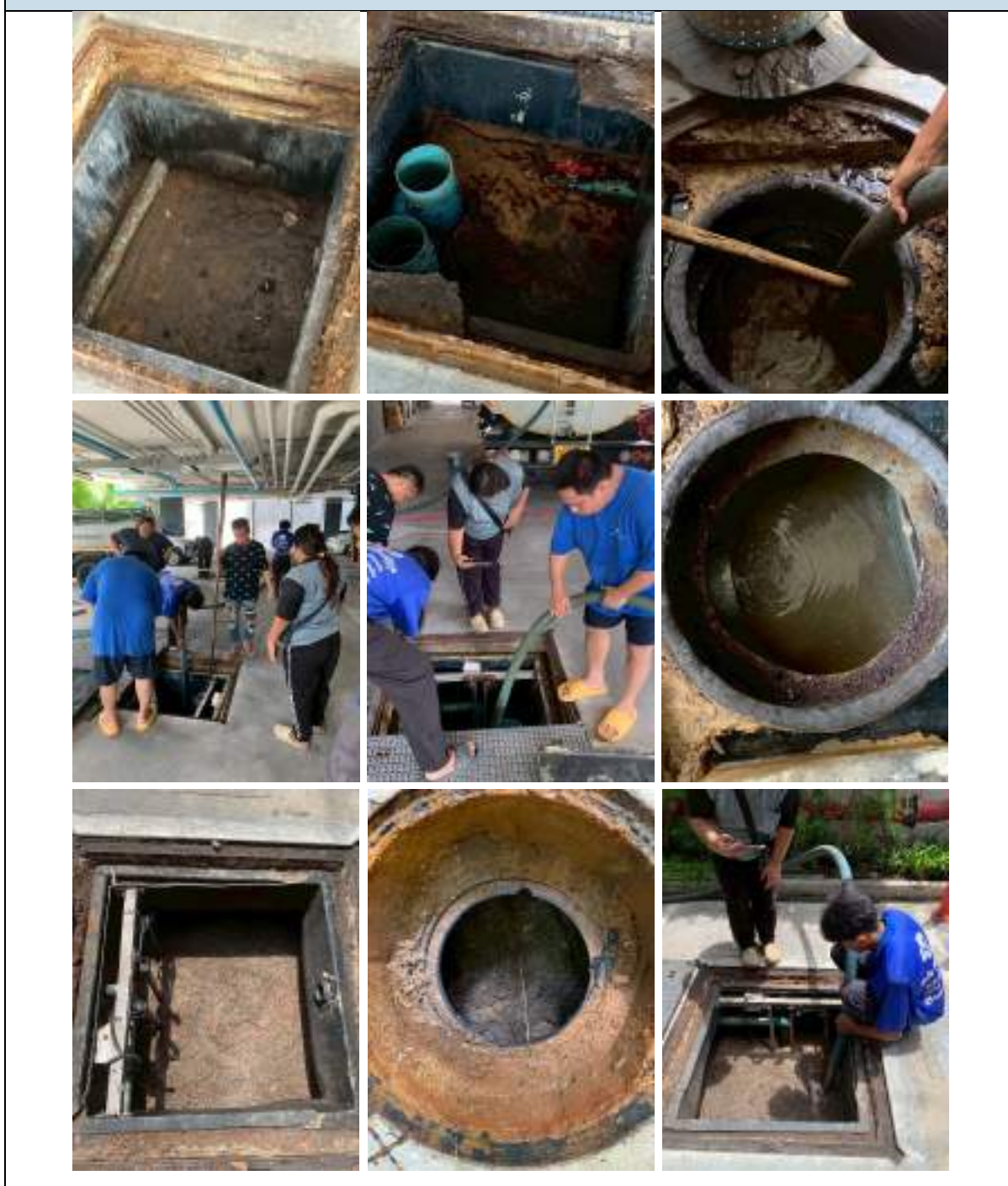
ภาคผนวกที่ 2.6 : จัดจ้างหน่วยงานเอกชนเข้ากำจัดกากตะกอนระบบบำบัดน้ำเสียตามที่กำหนด
