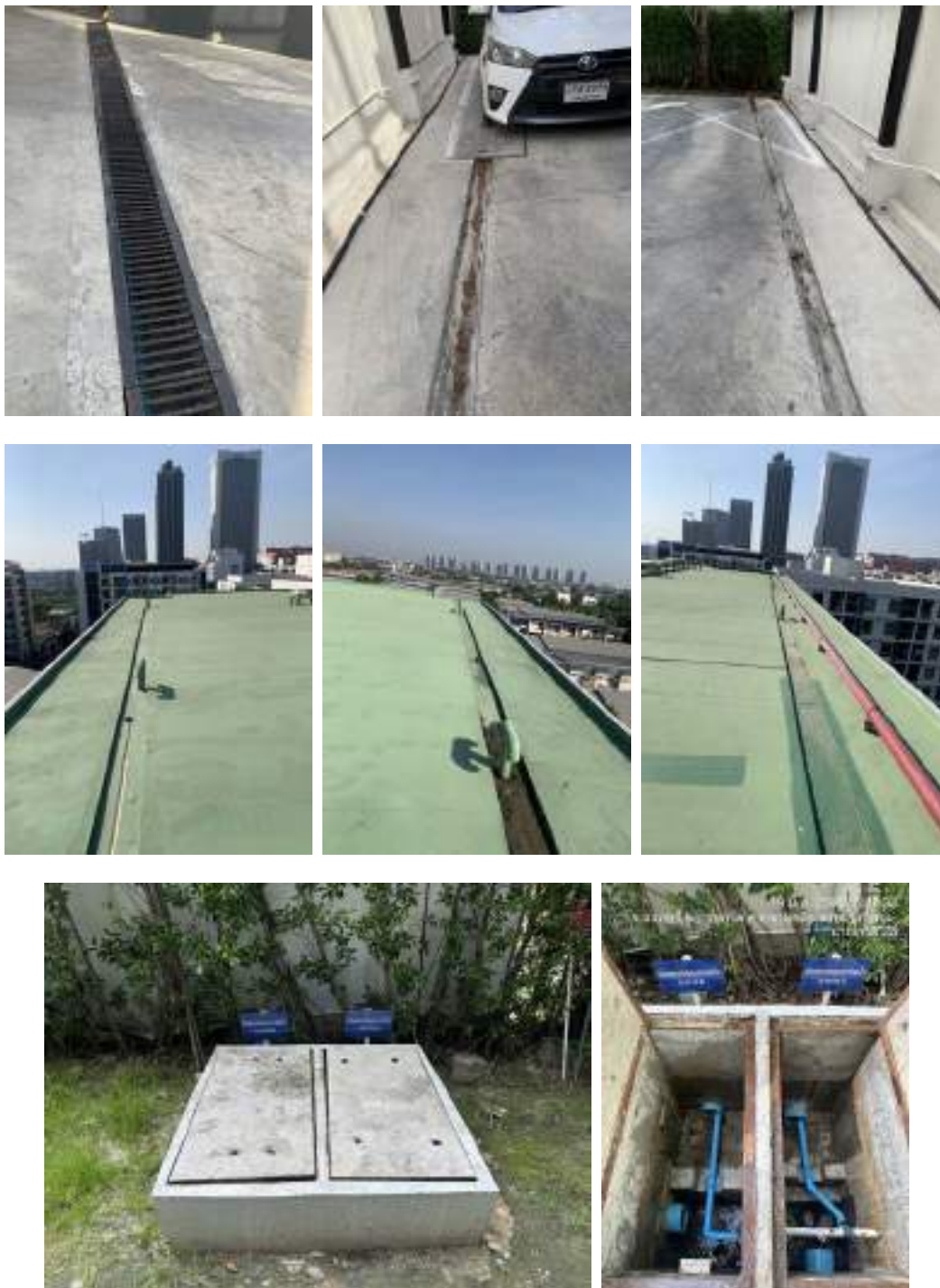
ภาคผนวกที่ 2.5 : รางระบายน้ำฝน – หัวรับน้ำฝน – บ่อพักบ่อสุดท้าย
